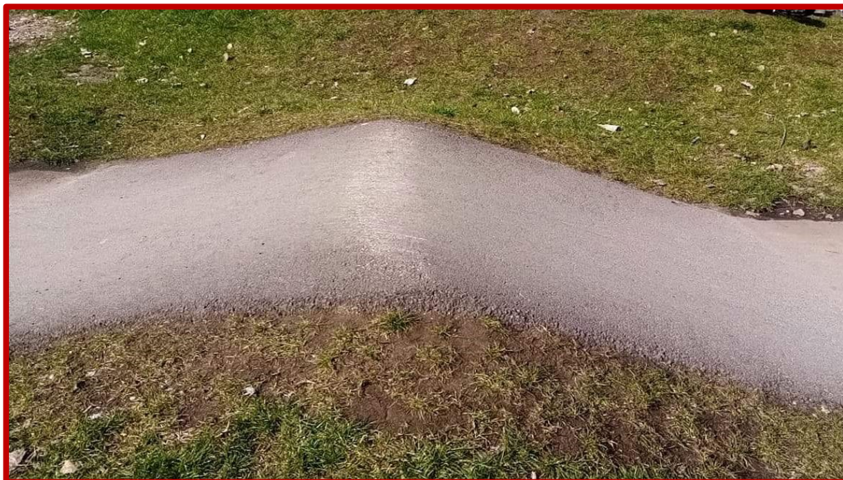
Ryc. 9 Niepoprawnie wyprofilowany garb – podjazd i zjazd płaski, szpiczasty kształt przeszkody
